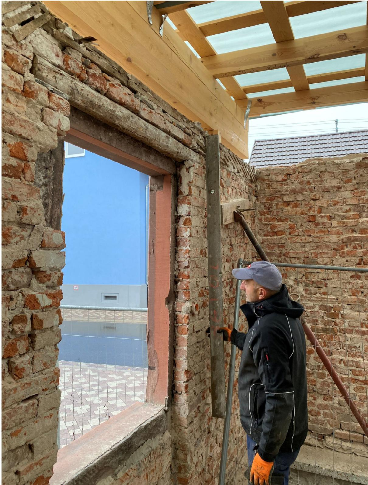
Foto 2: EG-Wand, zu erkennen ist die Auslenkung des Mauerwerks nach innen
