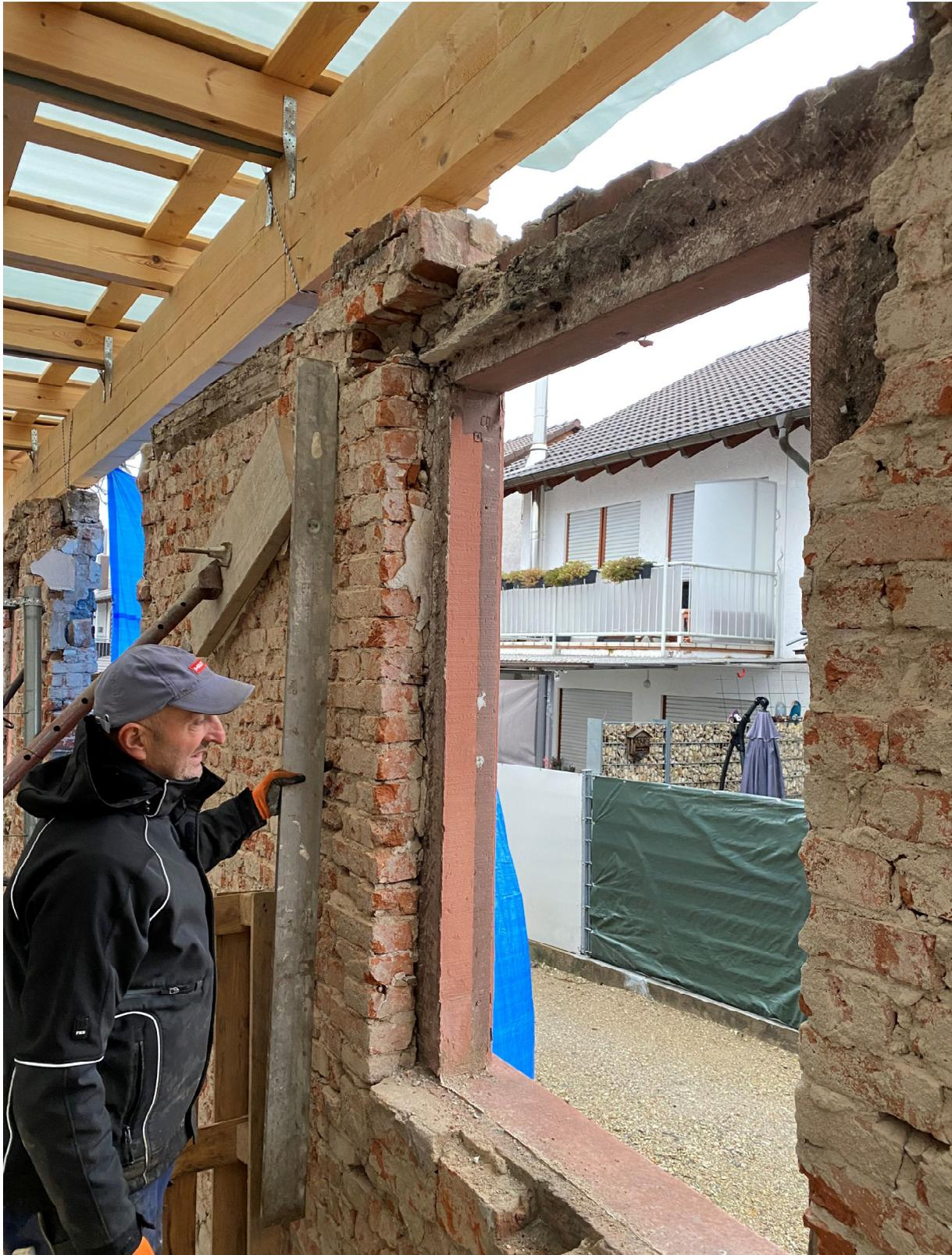
Foto 3: EG-Wand, zu erkennen ist die Auslenkung des Mauerwerks nach innen
