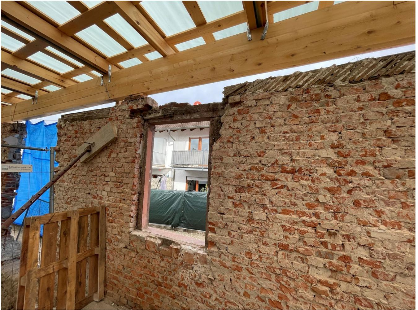
Foto 1: Außenwand EG mit provisorischem Dach
