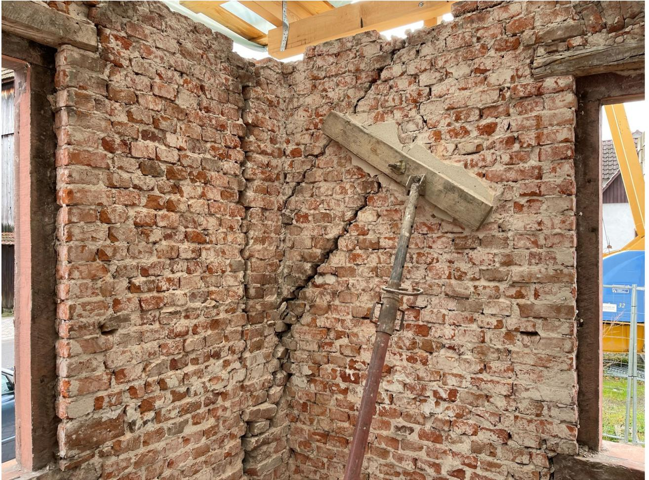
Foto 5: Ansicht auf die süd-östliche Wandecke, zu erkennen sind die abgerissenen Mauerwerksflanken
