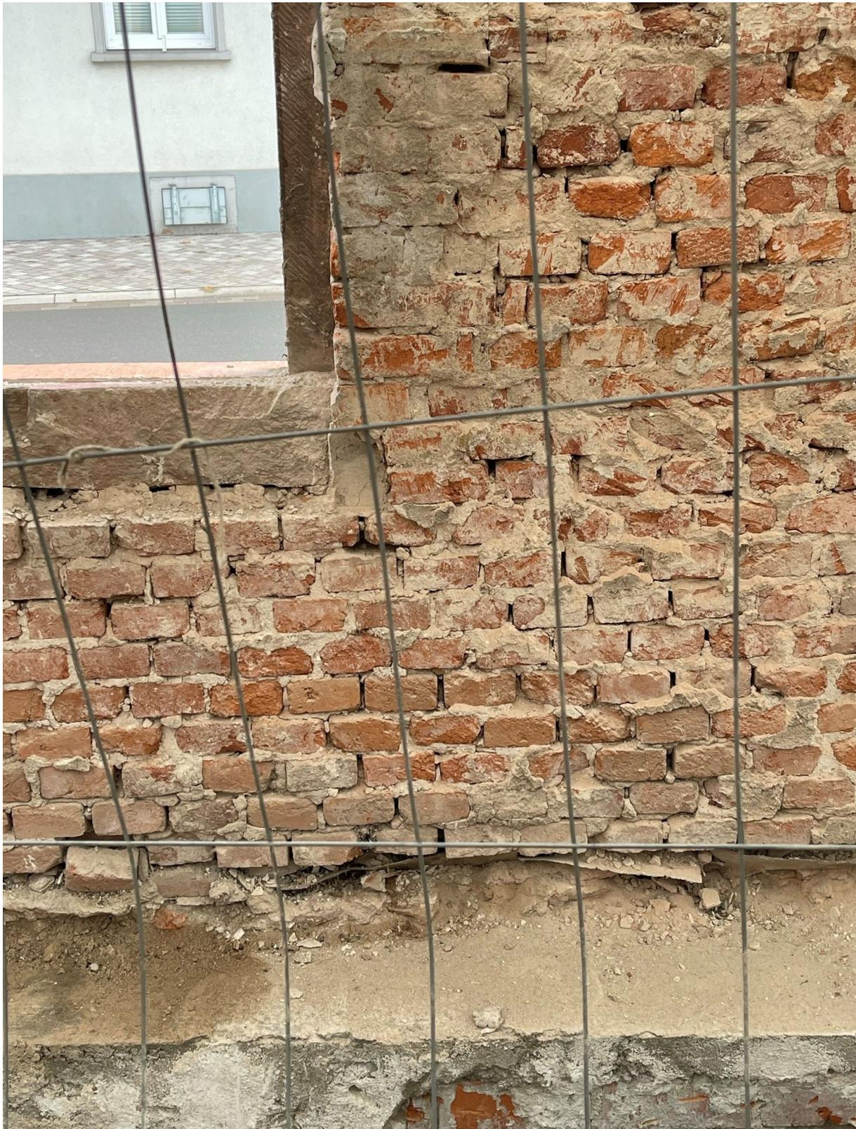
Foto 4: EG-Wand, zu erkennen sind die Fehlstellen im Mauerwerk
